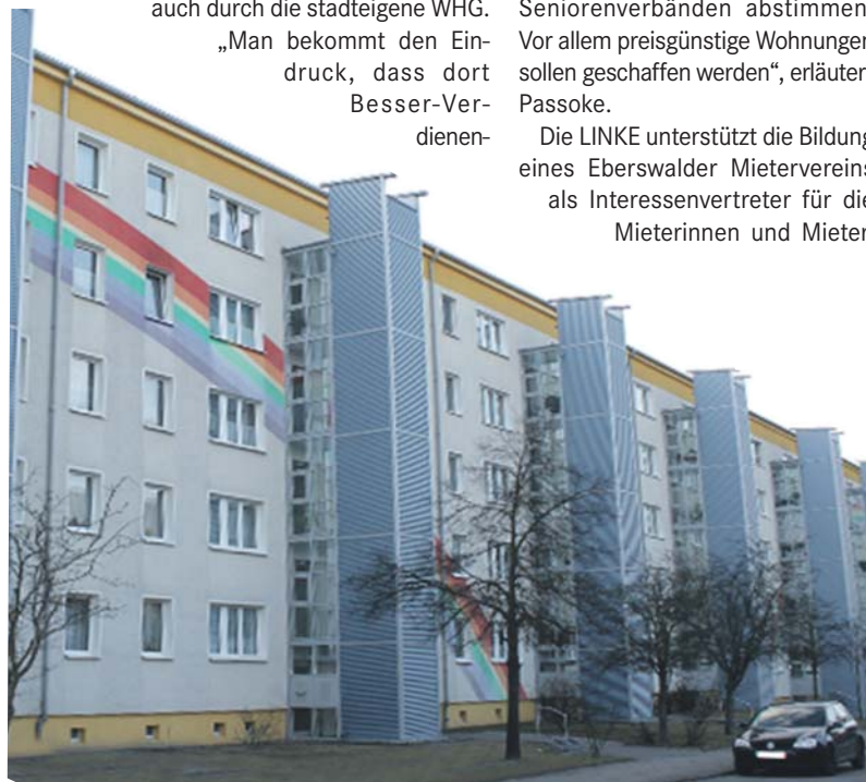
Sanierte Wohnungen in Finow. Preiswertes Wohnen muss jedoch auch im Eberswalder Stadtzentrum möglich sein. Foto: pb
