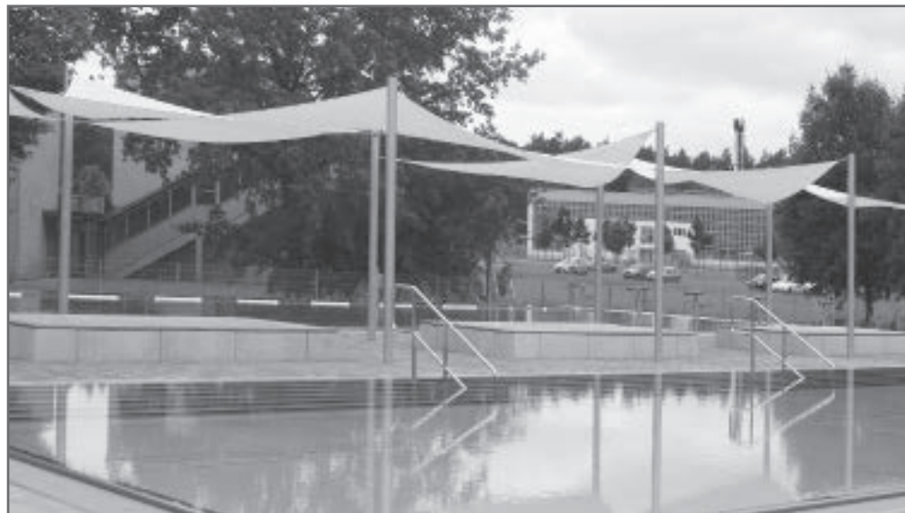
Pünktlich zum Saisonauftakt wurde das sanierte Freibad in Bernau-Waldfrieden dem Badebetrieb übergeben. Schwimmer können sich an der erhaltenen 50-Meter-Bahn erfreuen, Familien an den großen Liegewiesen, Kinder am Nichtschwimmerbecken und an den Sprungtürmen. Bernau ist damit um ein Schulsport- und ein Freizeitangebot reicher. Zum Tourismus und zum Rückkauf von Seen lesen Sie auf Seite 10/11. Foto: bc
