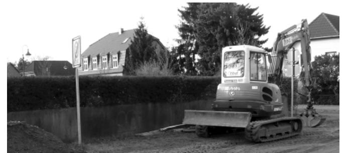
Bagger an der Solothurnstraße. Foto: WK
