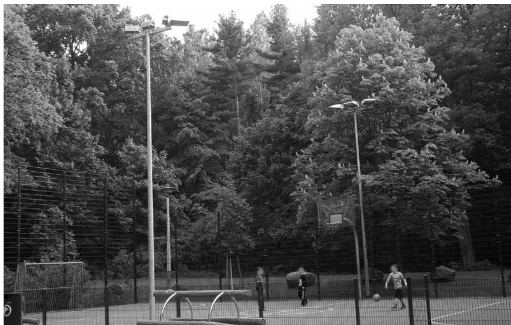
Endlich eine Flutlichtanlage am Bolzplatz „Schützenplatz“ in Eberswalde.
