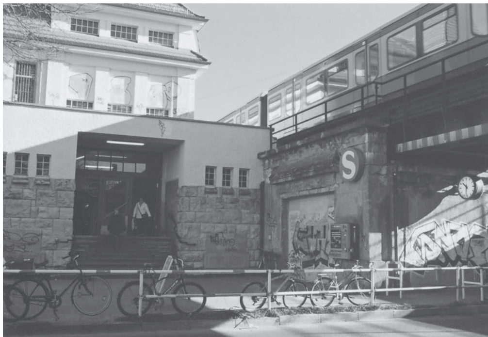
S-Bahnhof Zepernick: Im Berufsverkehr sind die Züge wieder überfüllt, weil die die Zuglänge wieder reduziert wurde und damit weniger Wagen zur Verfügung stehen. Foto: bc
