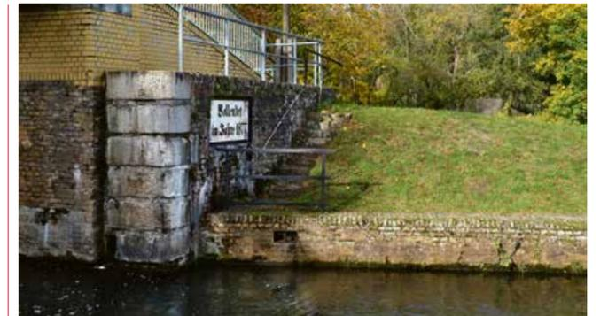
Der Zahn der Zeit nagt an den Schleusenanlagen wie hier an der Schleuse Ragöse. Es wird Zeit für eine Generalüberholung. Das gilt auch für die Schleusenammern und die Schleusentore.
